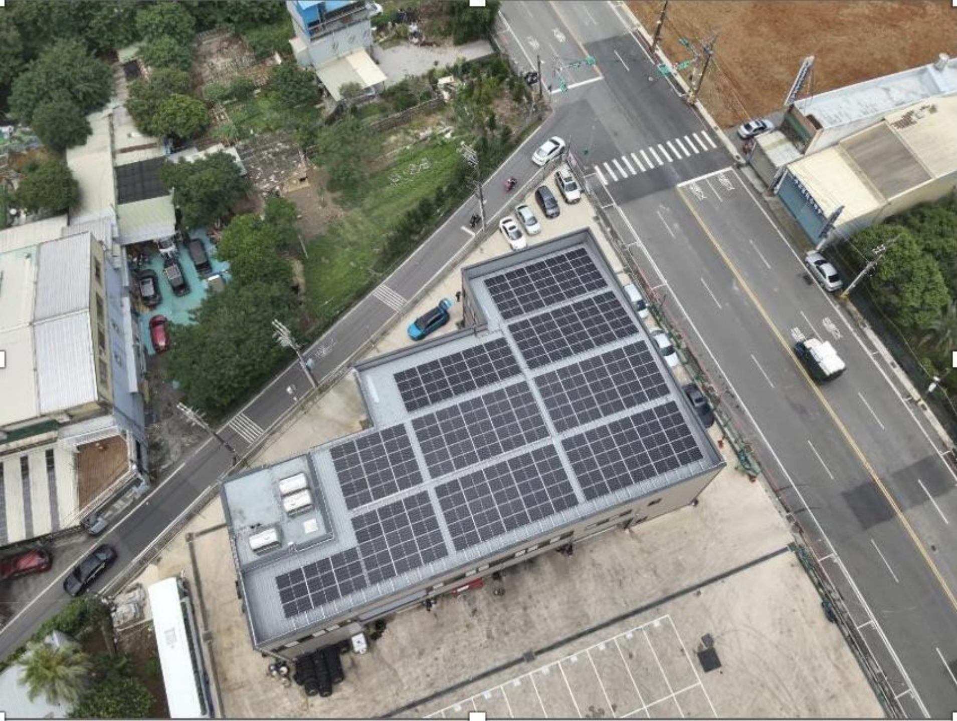
平鎮區廠辦 光電系統完工
