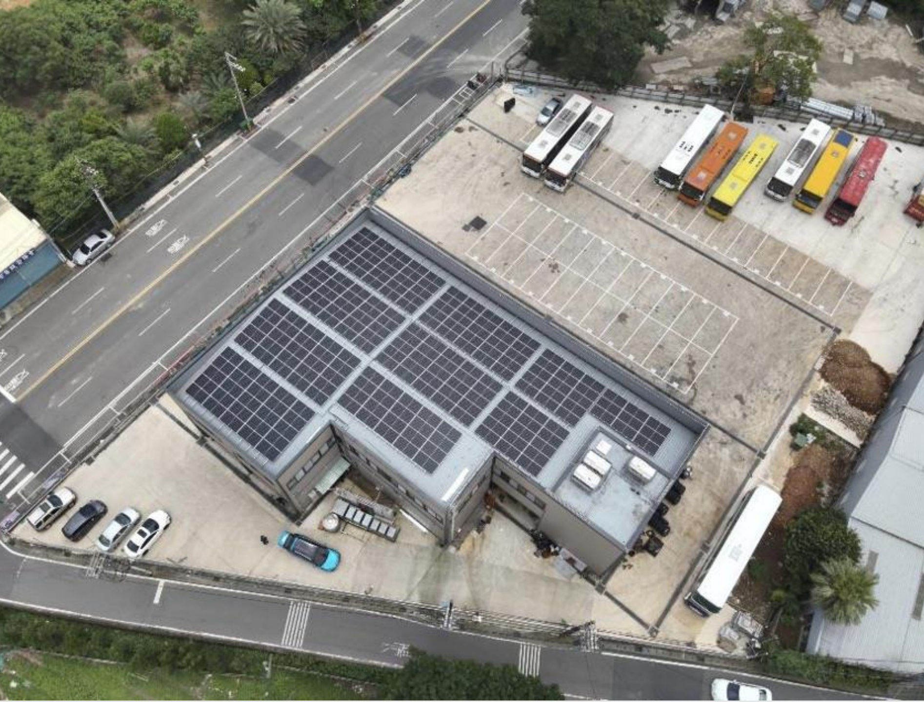
平鎮區廠辦 光電系統完工
