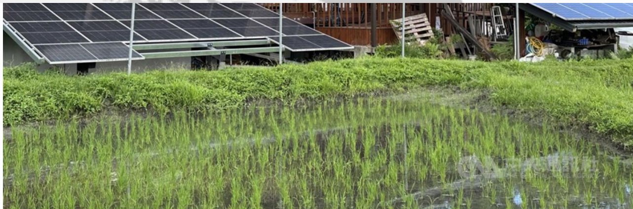
圖為台東家戶屋頂光電。(中央社檔案照片)
